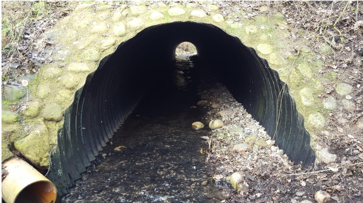
Figur 40 Nyetableret rørbro i Tågerup Bæk under Tågerupvej.
