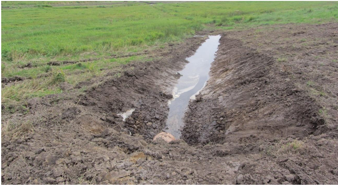
Figur 32 Eksempel på drænudløb i projektgrænsen til ny terrænnær grøft og videre udløb over terræn ved Birkemosen, Kolding.
